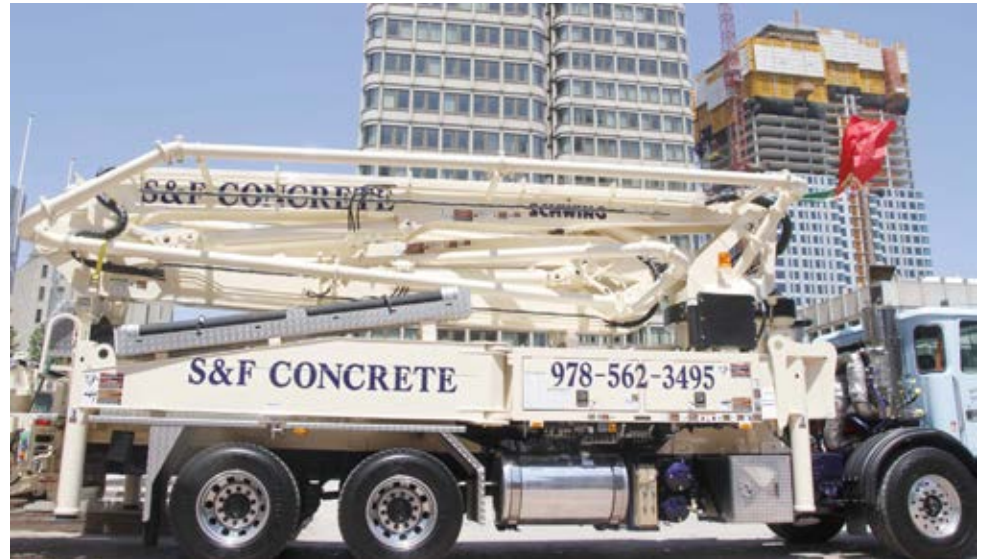
Na foto acima, a S&F Concrete fazia-se representar por um moderno e sofisticado camião, do mais moderno que existe no mercado para elevar o cimento a construções de torres habitacionais e comerciais.
